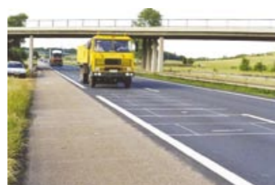
Pesage dynamique à vitesse réelle - LROP
