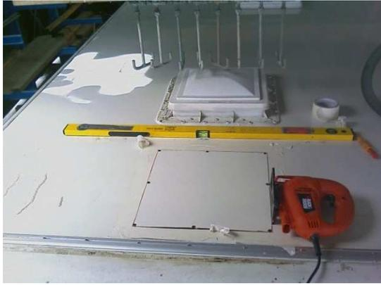
Etape 8 : remontage cheminée (au passage j'ai bricolé un joint moi-même dans ce tapis en caoutchouc car on ne vend ce joint qu'avec sa cheminée.. coût 30€), remontage passage de l'antenne TV et placement de la cornière arrière..
