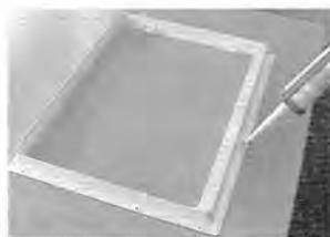
1. Imperméabiliser le cadre d'installation.
