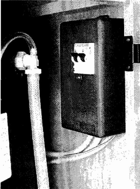
L'installation à 230 V devra être protégée selon les prescriptions locales en vigueur par un disjoncteur 10 A ou 16 A. Le coffre du disjoncteur se trouve dans la partie basse de la penderie ou sous la dînette.
